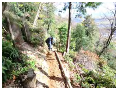
歩道の補修作業
