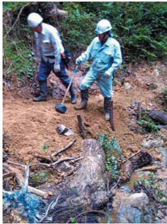
復旧作業状況
